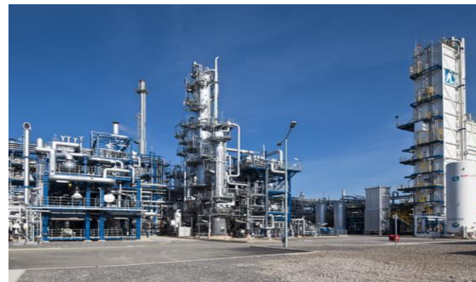
Impianto per la produzione di 22.000 t/anno di idrogeno da steam reforming del metano nei pressi di Colonia (DE).Fonte: Air Liquide, 2015
